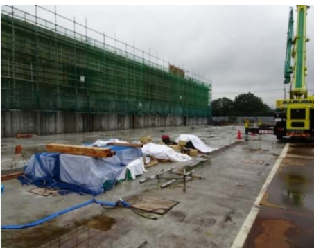
この建物が管理棟になります 結構大きな建物です
