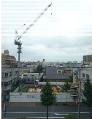
工事が始まったもくせい会館
