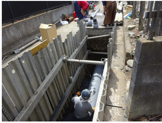
雨水管理設工事
