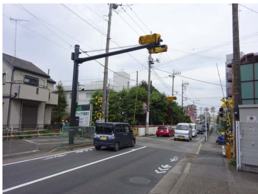
踏切の上には信号機が設置されました
