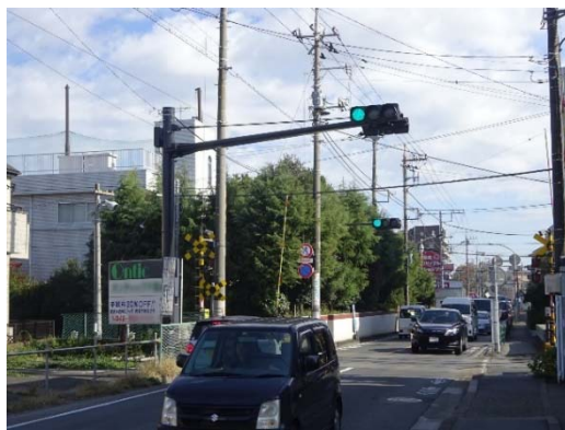
新設された踏切信号機
