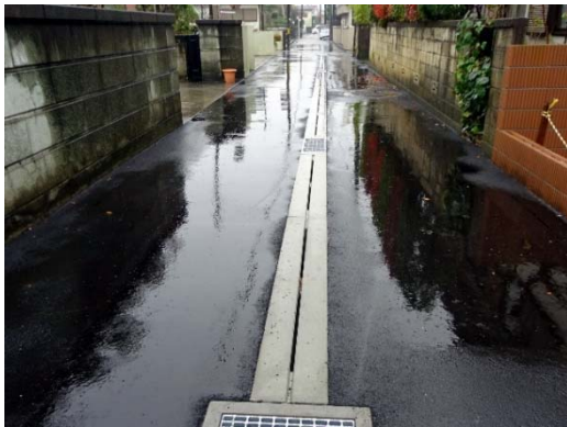
新設された排水溝
