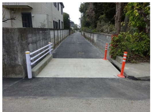
改良された市道251号線
